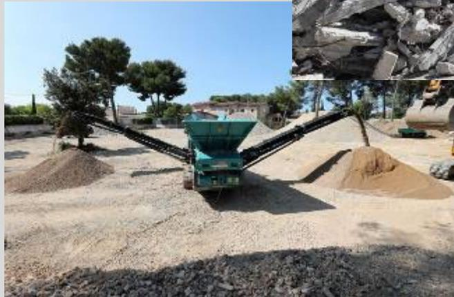
Déconstruction et concassage des gravats utilisés par la suite en fond de forme
