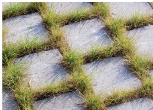
Principe du cheminement avec joints plantés
