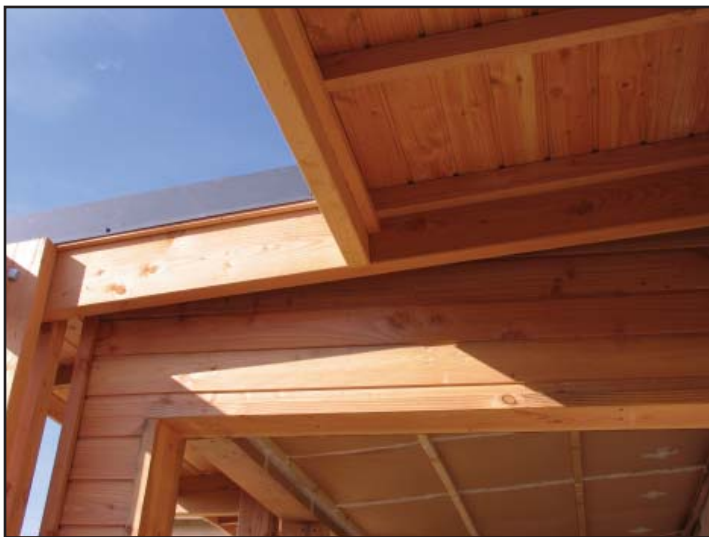
Structure bois, niveau 1
