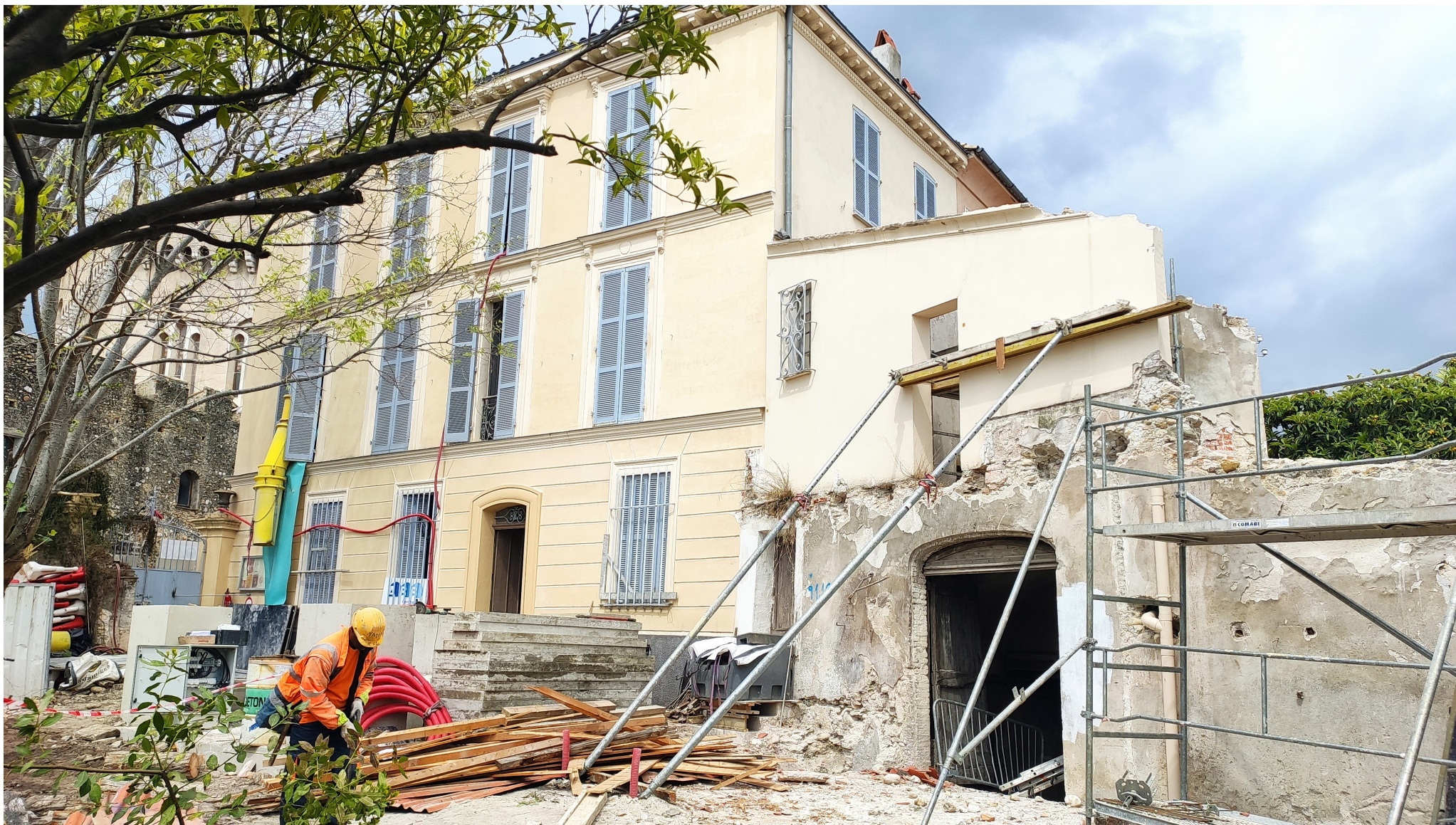
Un chantier en centre ancien contraint
