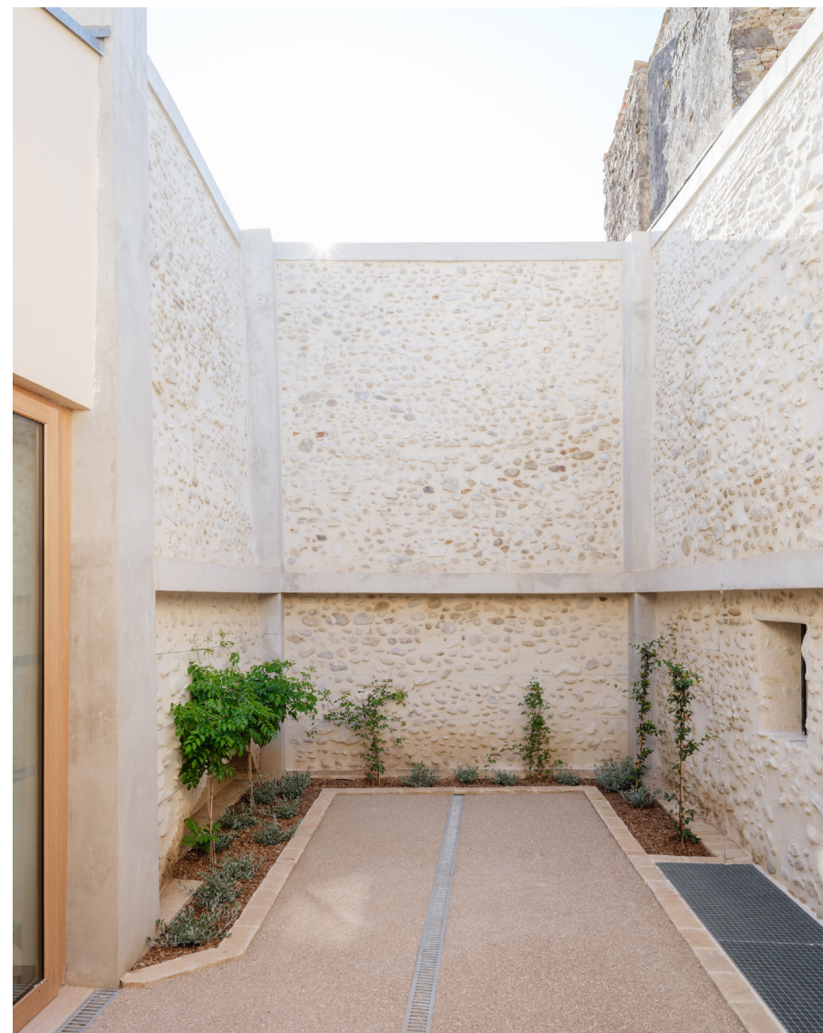
Patio du réfectoire. Les murs mitoyens ont dû être renforcés après les démolitions pour ne pas perturber l'équilibre structurel de l'îlot.
