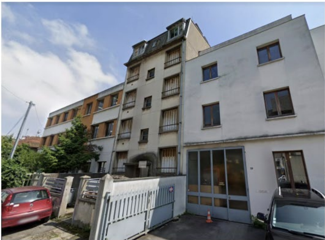
Façade de l'ensemble immobilier avant travaux
