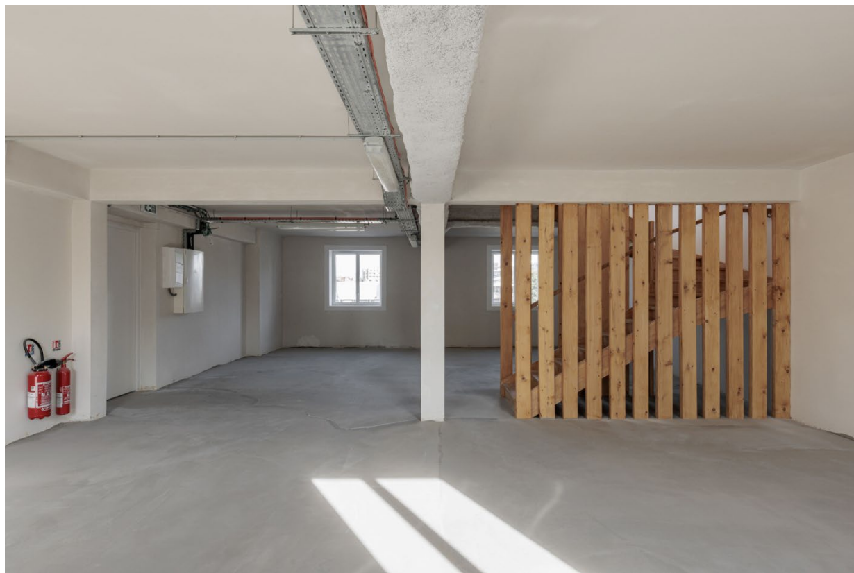
→ Bois de banchage réutilisé pour les aménagements
