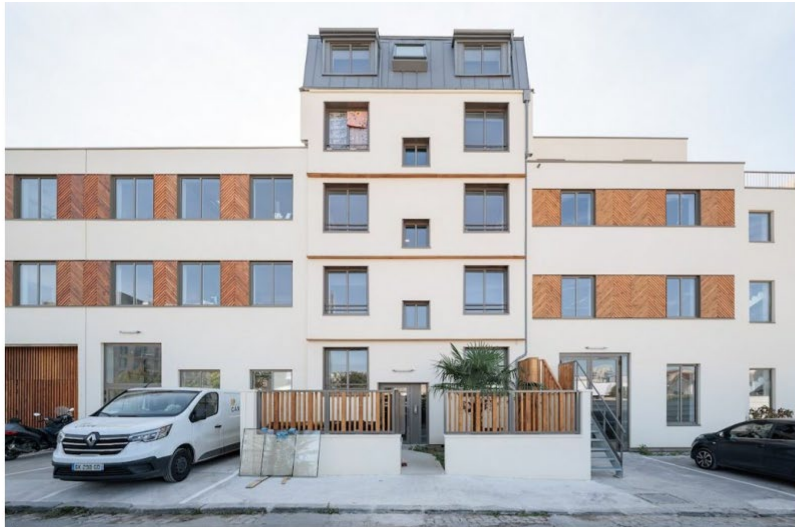
Façade de l'ensemble immobilier après travaux en Septembre 2023 - côté rue
