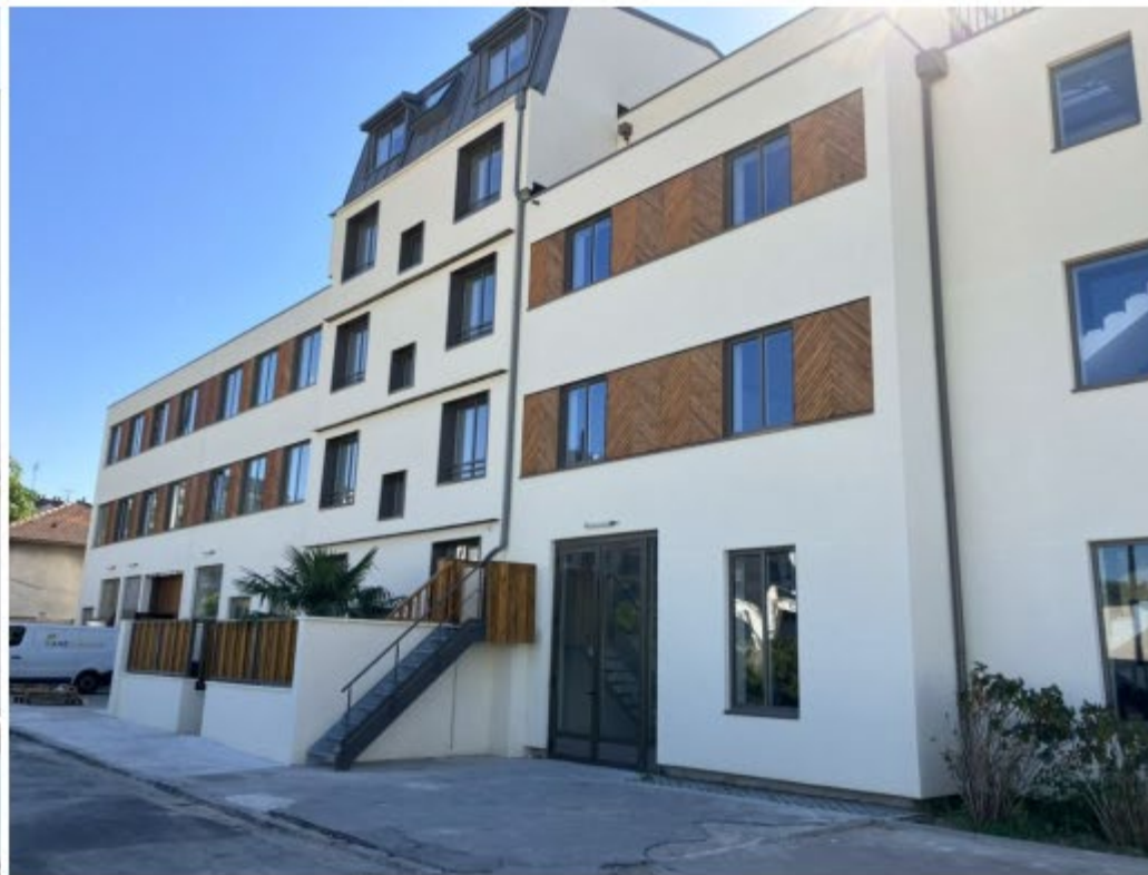
Façade de l'ensemble immobilier après travaux en Septembre 2023
