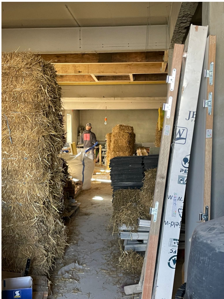
→ Entreposage de la paille à l'intérieur du bâtiment
