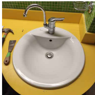
Réutilisation des lavabos
