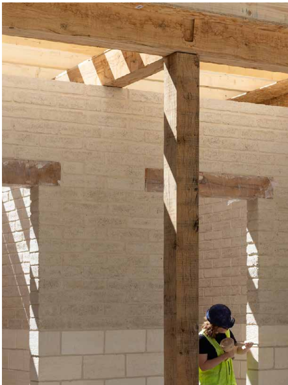
Utilisation en partie supérieure et en intérieur des BTC restantes du lot 8 Utilisation de blocs de pierre de Fontvieille en extérieur et en soubassement. Finition baadigeon épongé pour unifier le tout
