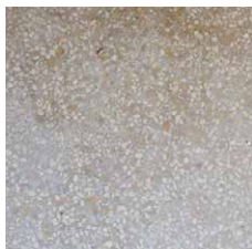
Sol salles de bain - RDC
