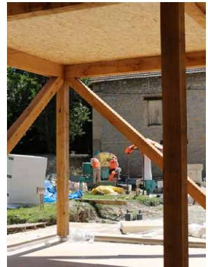
Présentation 6 Chantier en cours
