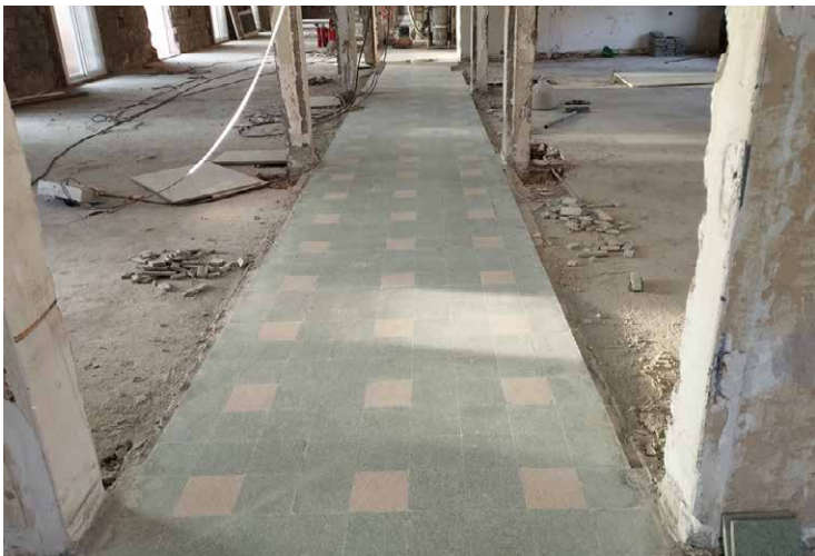
Retrouver les carreaux de granito et les carreaux de ciment sous les sols souples
