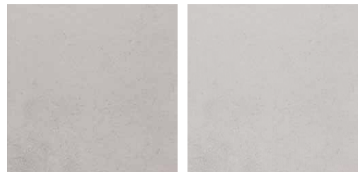
Enduit type 1 Ref: Echantillon II, ou même mélange que block A au lot 8, Enduit serré
