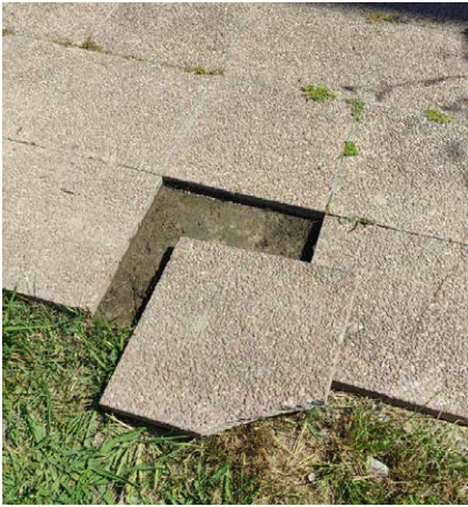
Récupération des dalles gravillonnées ponçées
