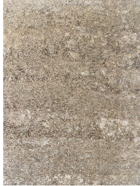
Photographie 13 : Mur béton de paille de lavande/in laissé apparent du CRIEPPAM
