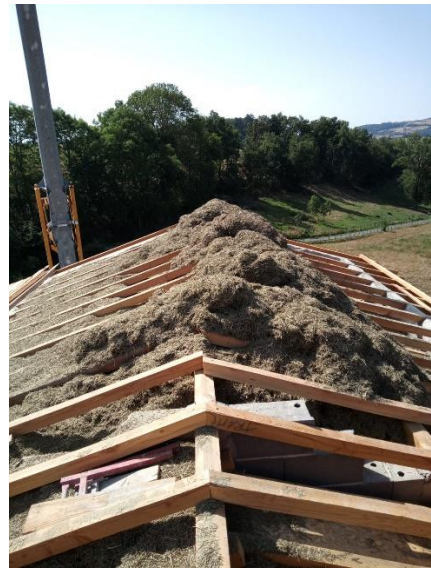
Photographie 10 : Toiture de la maison de P. Tressere – 69
