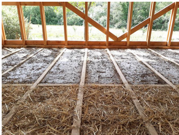
Photographie 14 : Plancher du local maraîcher en hourdis Crédit : Paille Hom' (Faraldo, s.d.)
