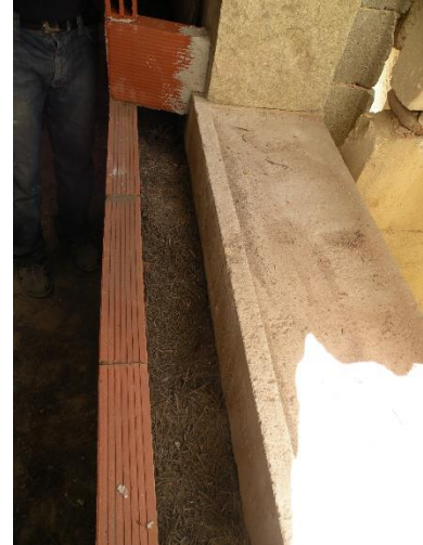
Photographie 11 : Mur brique – parpaing remplissage paille de lavande
