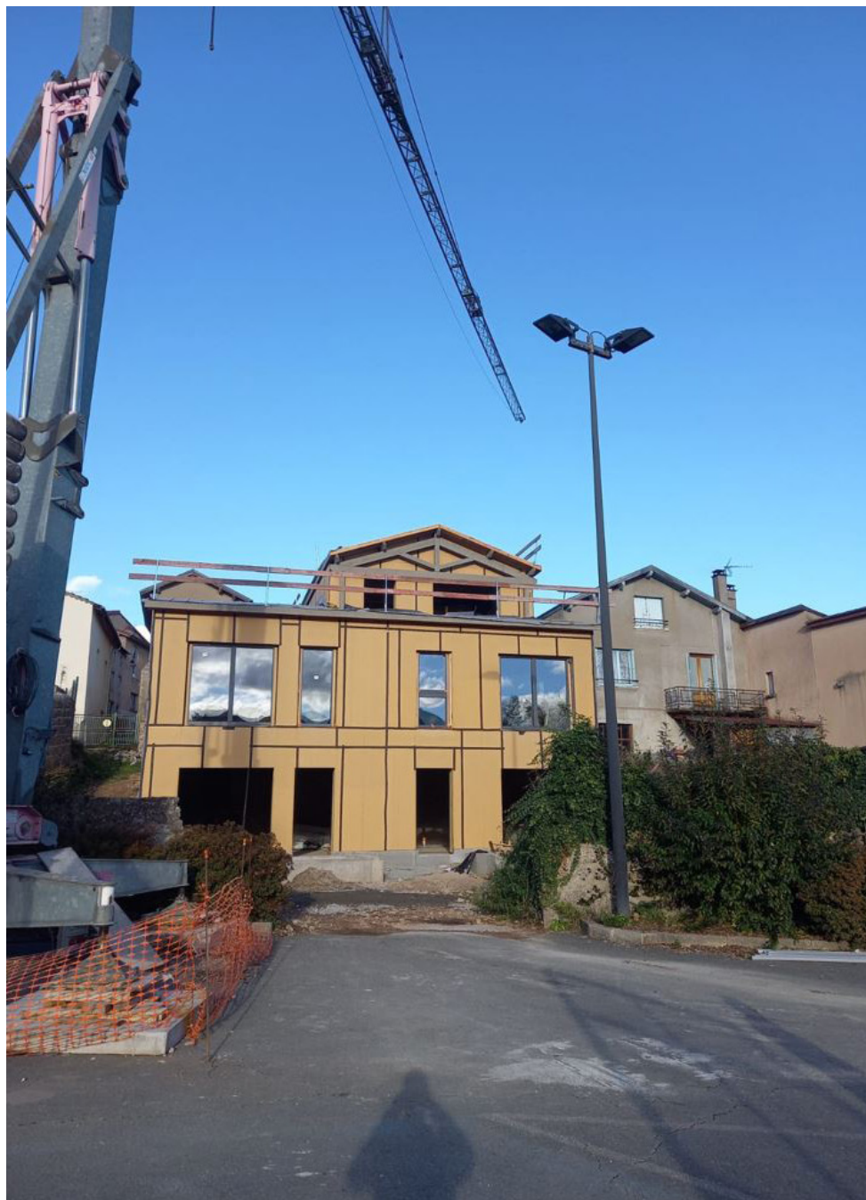
Montage du volume à l'aide d'une grue - © Lignatech
