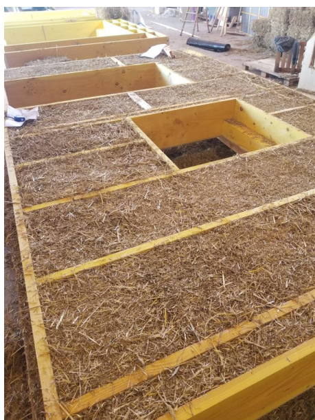
Mur préfabriqué avec remplissage paille © Lignatech
