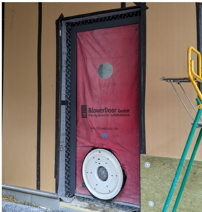
La mesure a été réalisée en une seule fois sur tout le bâtiment à l'aide de 2 portes soufflantes aux opposés du bâtiment ©Atelier d'architecture Rivat
