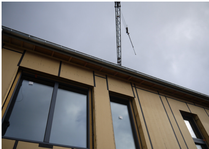
Caissons préfabriqués assemblés sur site à l'aide d'un moyen de levage adapté
