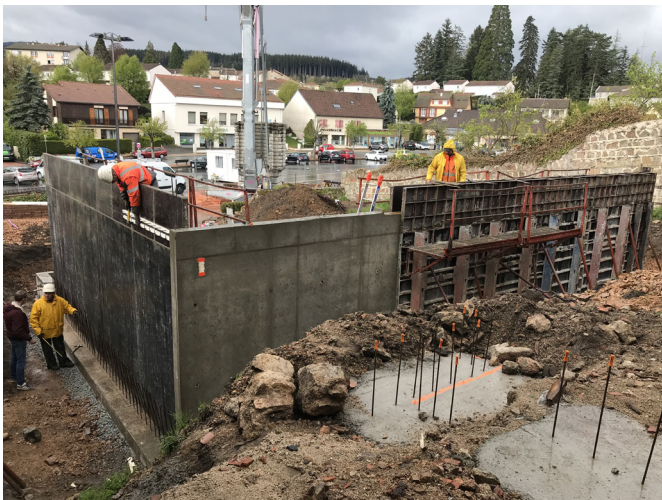
Coulage des murs de soutènement - ©Atelier d'architecture Rivat
