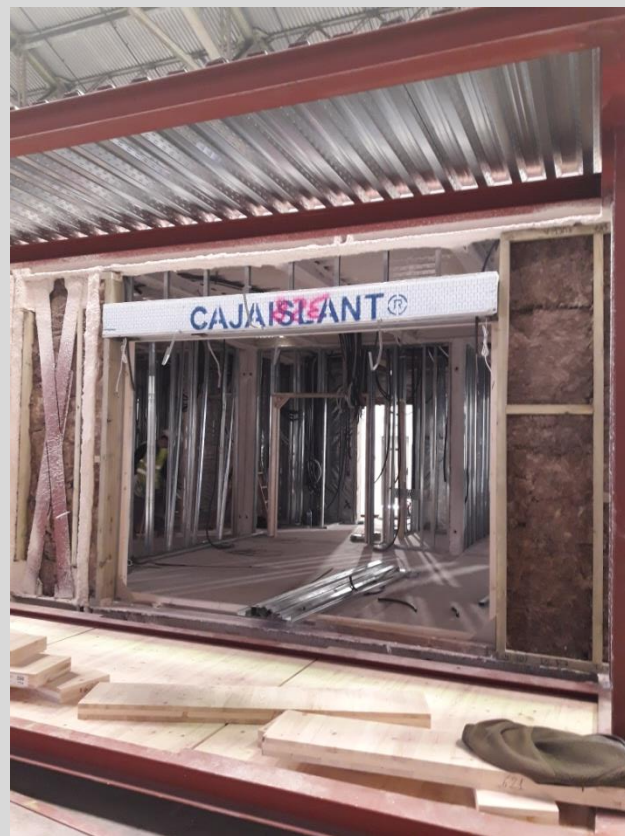
Pose des coffres de VR
