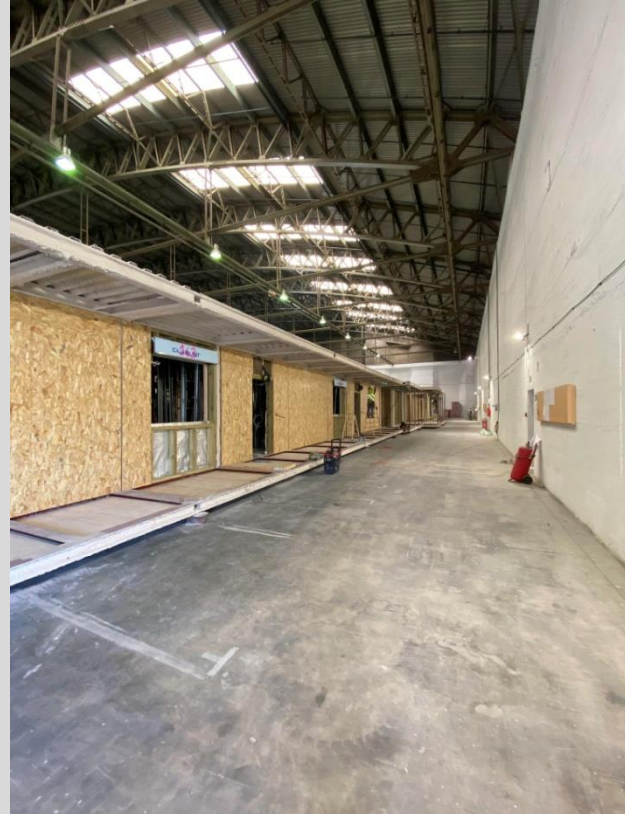
OSB à l'extérieur en façade
