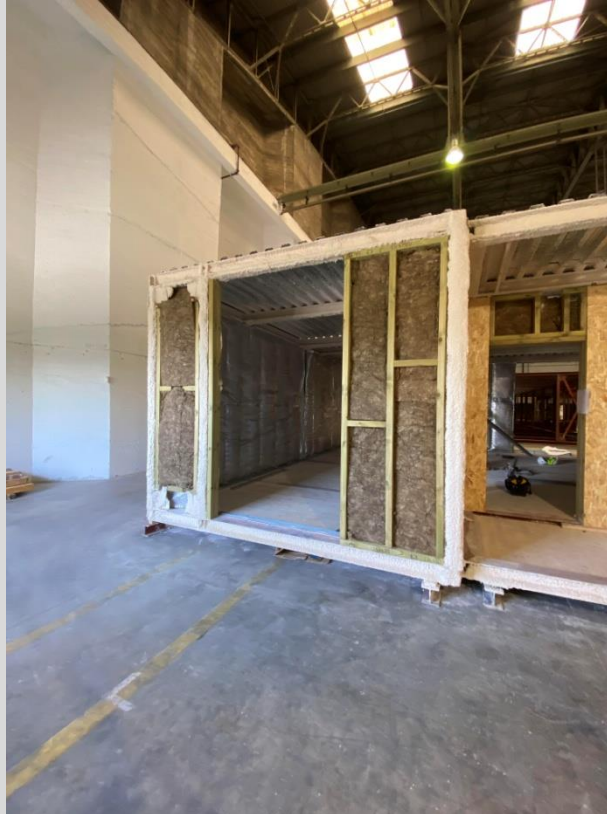
Ajout de l'isolant entre montants
