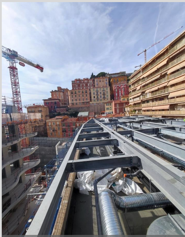
Structure métallique sur vide technique existant/surélévation
