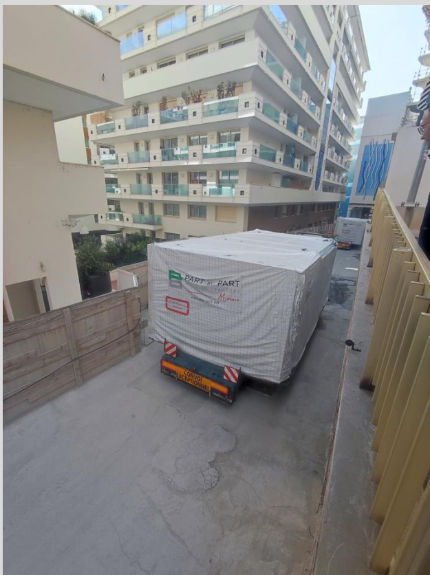
Livraison des modules par camions
