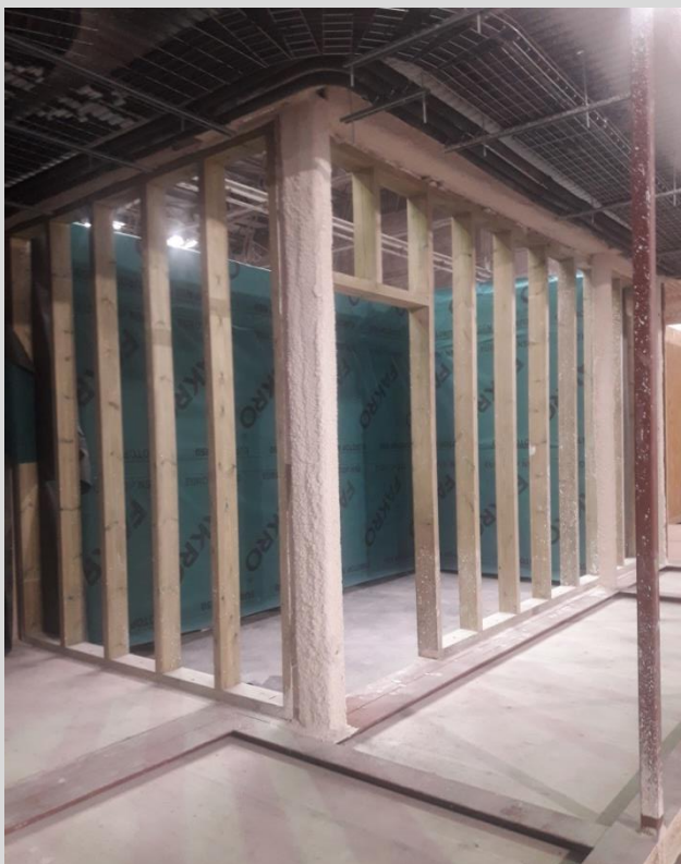
Ossature bois des façades (Composition : Mèlèzes)
