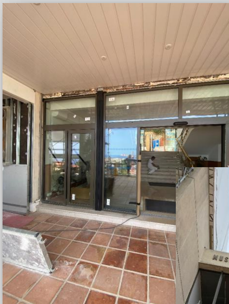
Remplacement châssis ALU hall RDC/R+1
