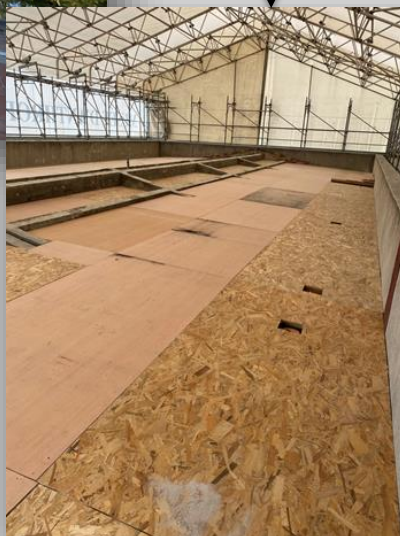
Panneaux OSB réemploi Aile Sud
