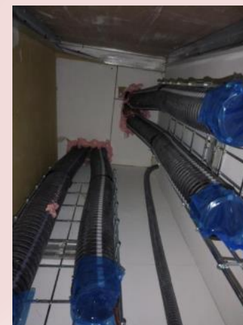
Infiltrations traversées de plancher
