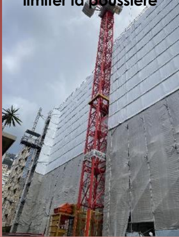
Bâches épaisses sur échafaudage pour limiter la poussière
