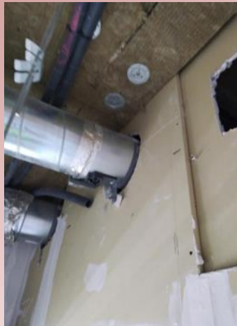
Infiltrations traversées de cloison par les réseaux
