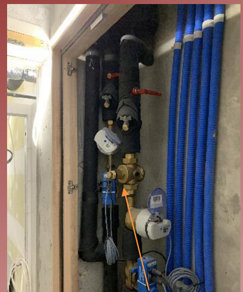
Comptage volumétrique EF + détecteur de fuites swtch flow
