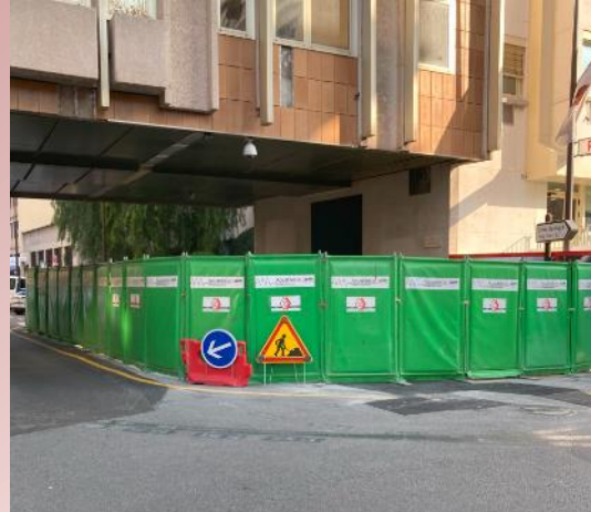
Clôture acoustique lors des travaux bruyants
