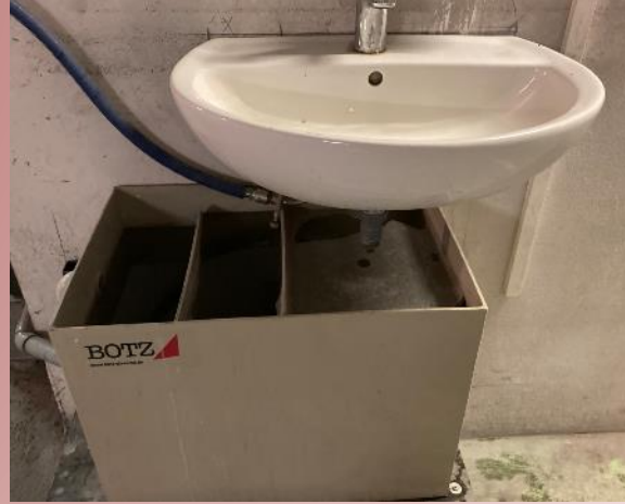
Système de décantation pour lavage des outils
