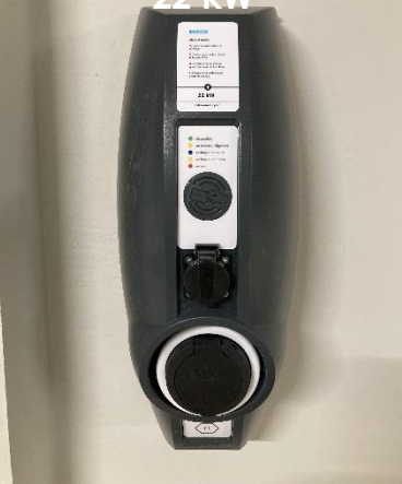
Borne recharge électrique 22 kW
