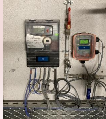
Comptage énergétique départs EC, EG, ECS
