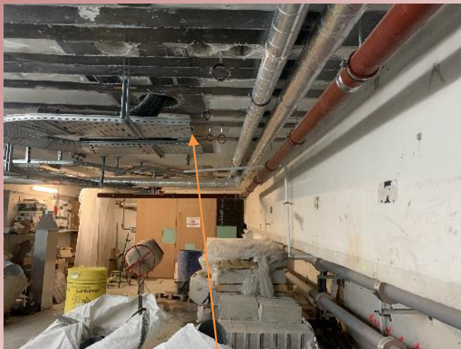
Renforcement structurelle par plats carbonnes
