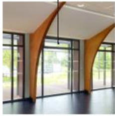
Ouvrants en imposte pour la ventilation
