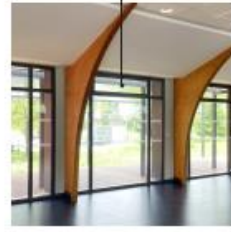
Ouvrants en imposte pour la ventilation
