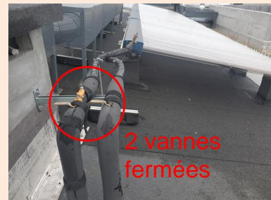
Sur les 14 panneaux solaires thermiques installés, seulement 9 panneaux fonctionnent correctement
