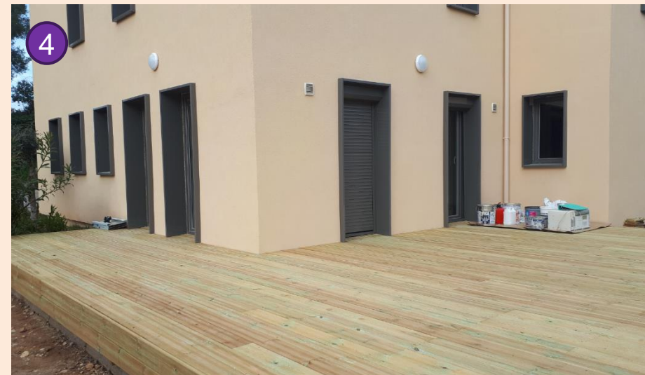
Angle Sud-Est et Sud-Ouest
