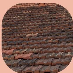
Toiture en tuiles marseillaise de réemploi. Les différents modèles sont panachés.
