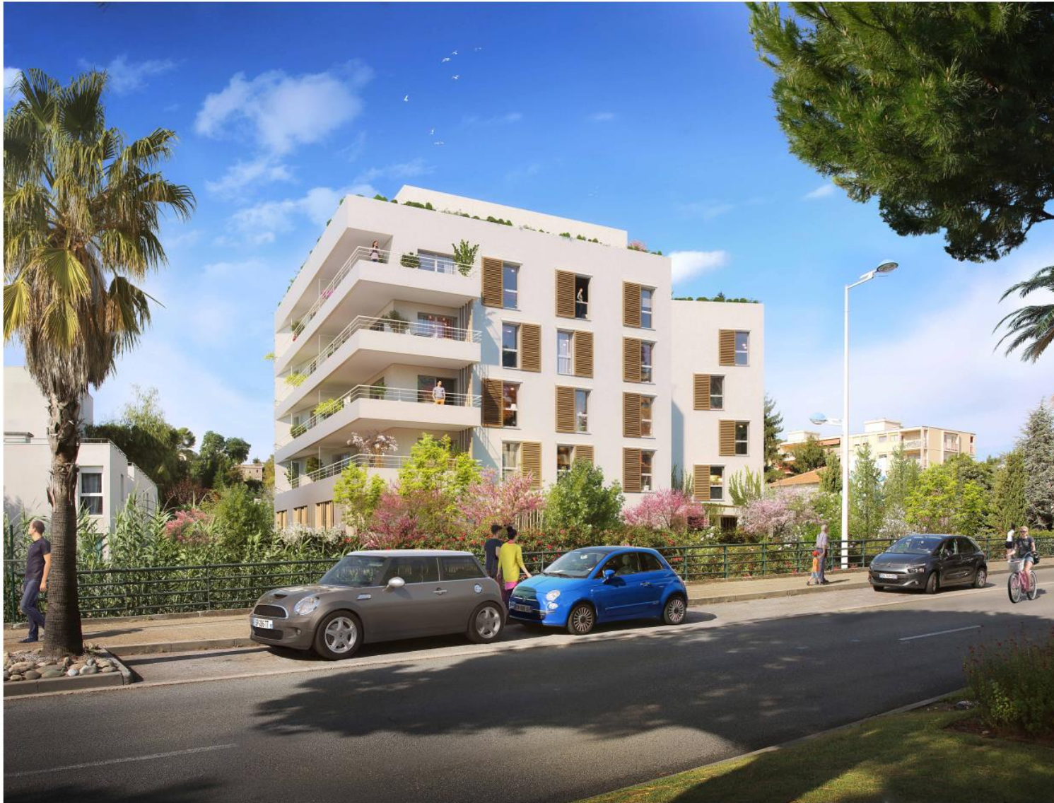
Vue depuis l'avenue des Alpes
