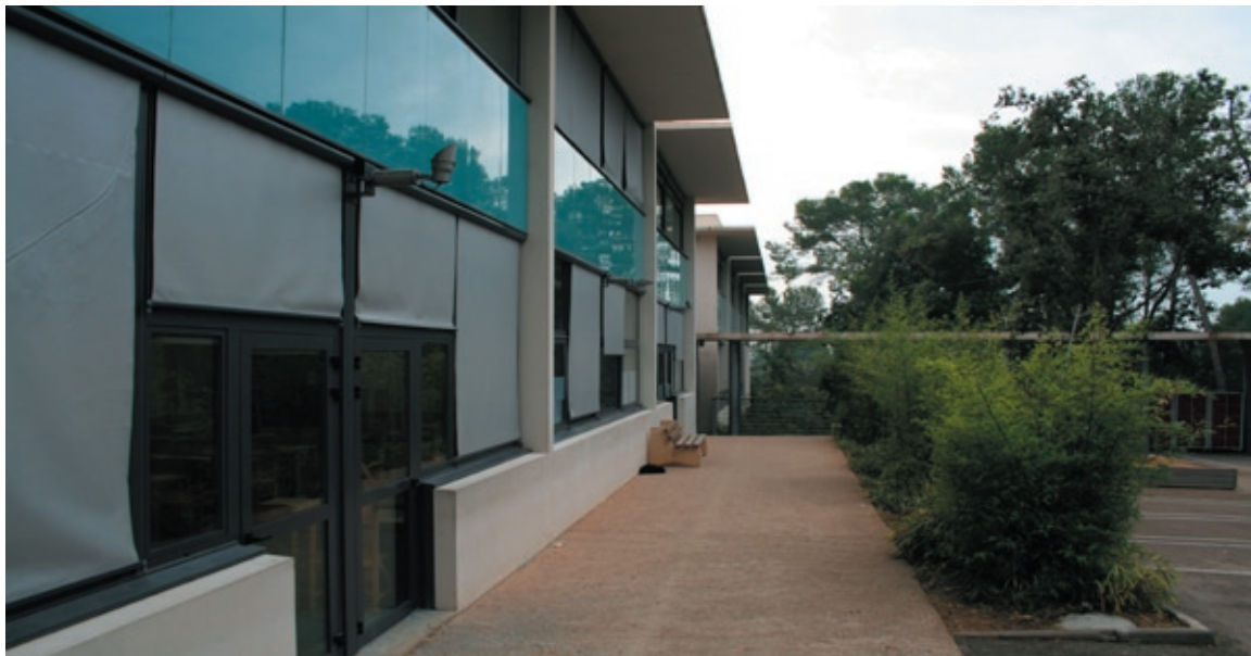
Vue de la façade Ouest du collège
