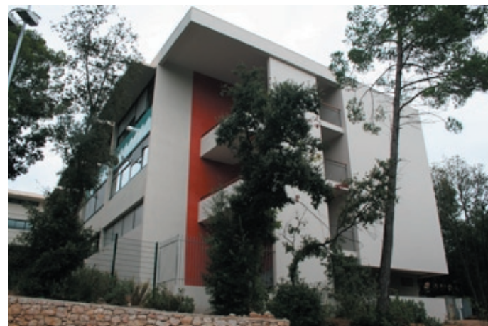
Vue de l'angle Sud-Ouest du bâtiment.
