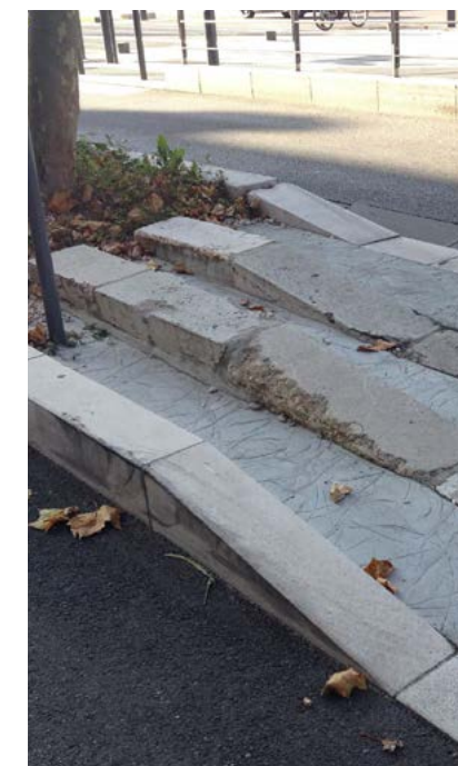
Sol en béton de réemploi (Grenoble - Villes et Paysages)
