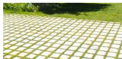
Dalles béton et joints enherbés ( Cassis )
