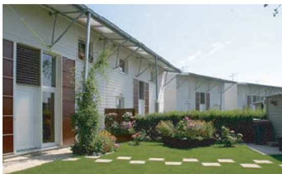
Photo 13 : Logements du Jardin des Saveurs Photos ci-dessus [réf. 19]
