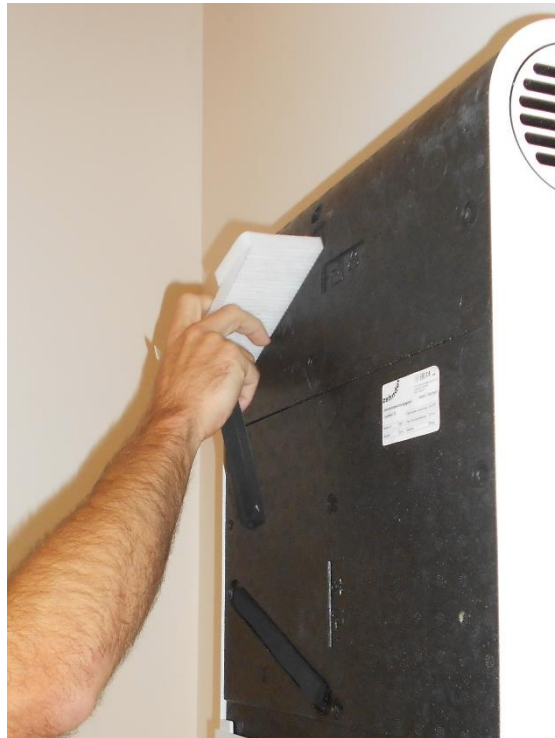
Changement de filtre d'une ventilation double flux décentralisée
