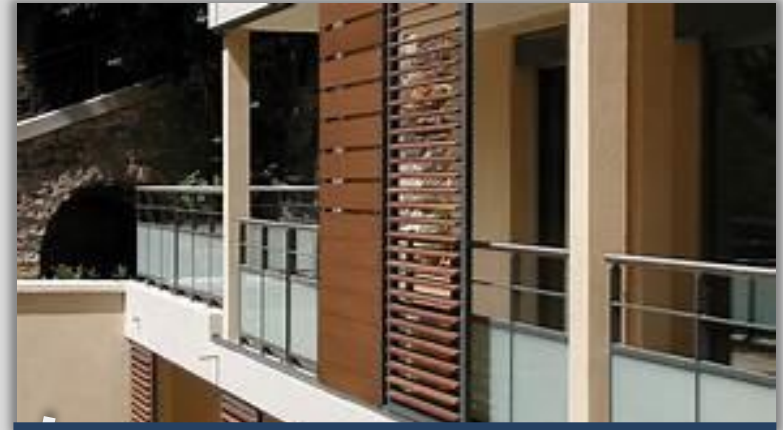
Panneaux Brises Soleil coulissants Tous étages Aile Nord et R+1 à R+3 Aile Sud
