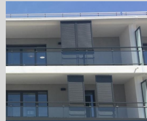
Panneaux Brises Soleil coulissants Tous étages
