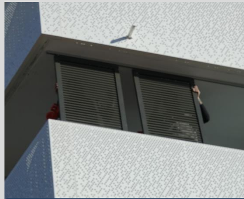
Panneaux Brises Soleil coulissants R+1 à R+3
