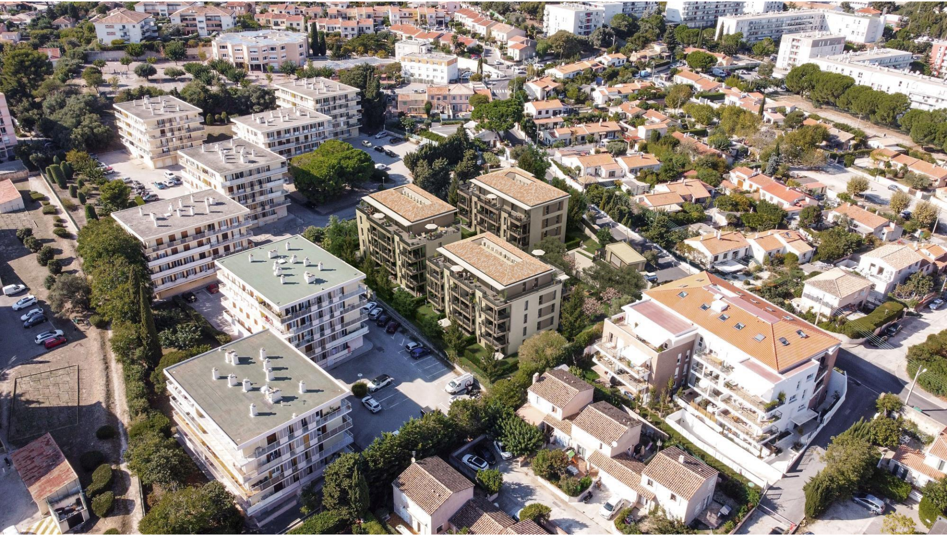
Vue sur les façades Sud et Est
