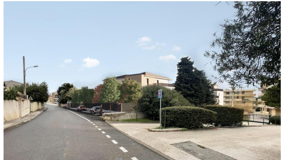
Vue sur les façades Nord et Ouest depuis l'avenue de la Marine
