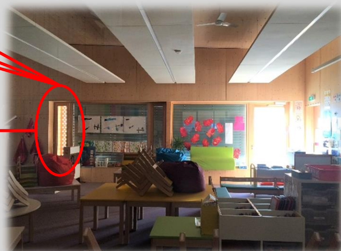
Ventilation naturelle de la façade sud (protection bois perforé) et tourelle
