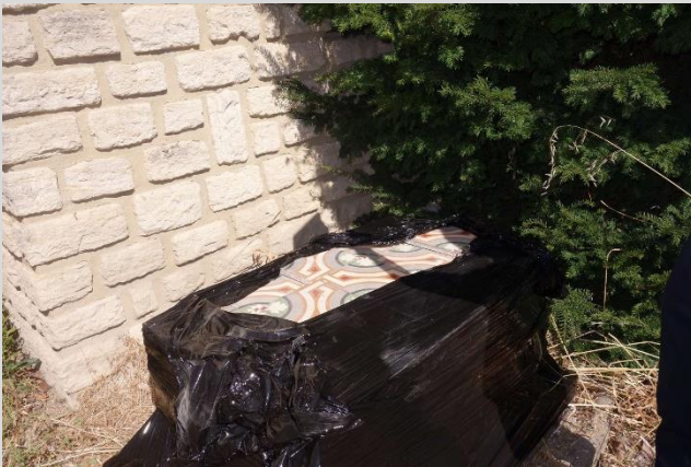
Stockage des carreaux de ciment durant le chantier
