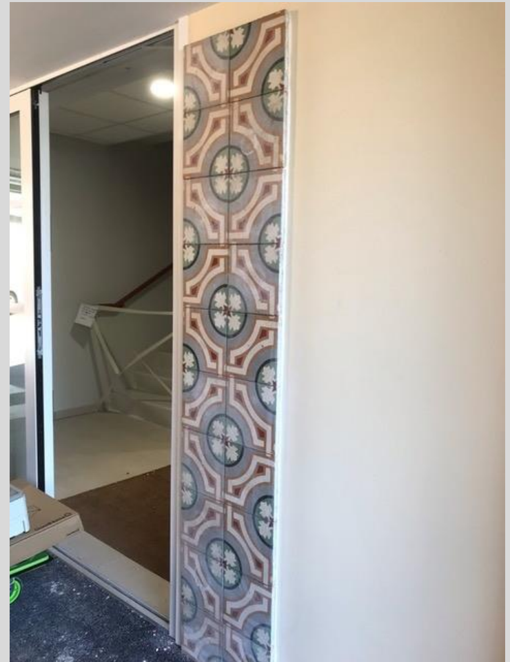
Réutilisation des carreaux de ciment dans l'entrée de l'îlot 2
