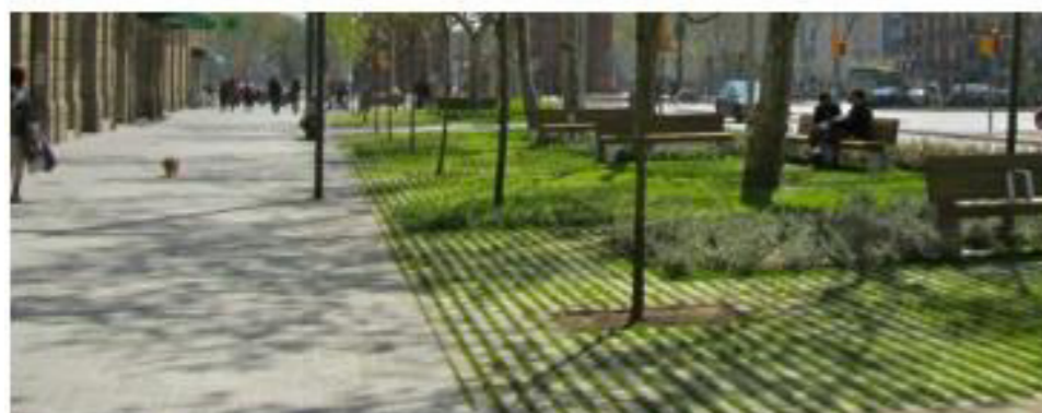
Barrettes en pierre ou en béton avec et sans joints enherbés
