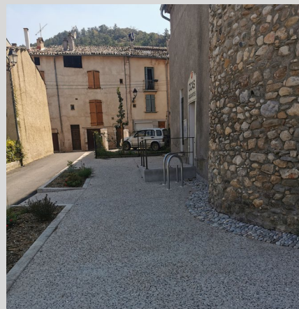
Enrobé pour la voirie, stabilisé pour cheminement et trottoirs
