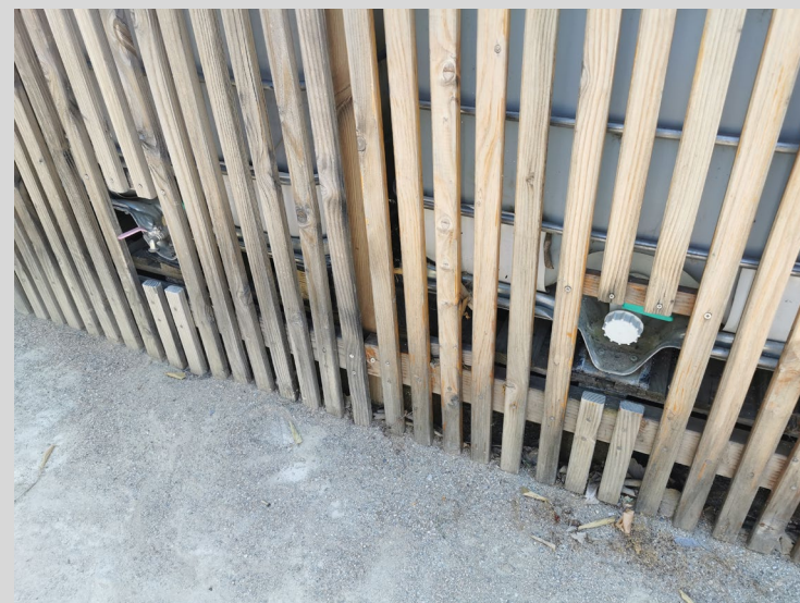
Cuves de récupération des eaux pluviales
