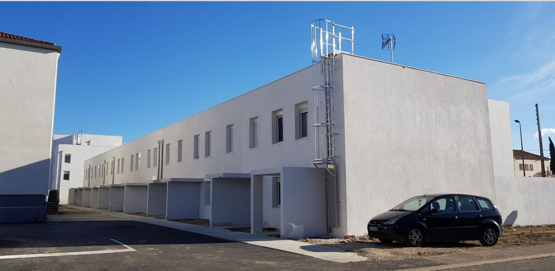
Façade Nord Ouest
