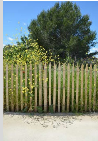
Clôture en ganivelles
