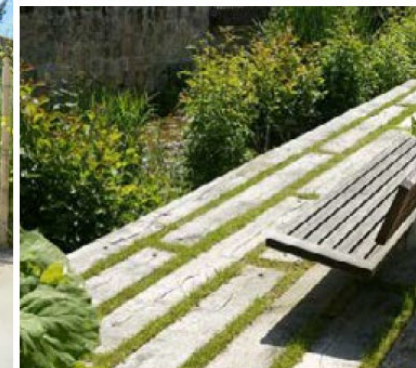
Pas en béton avec joints végétalisés
