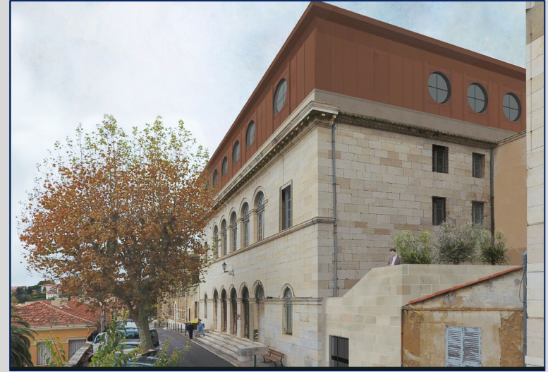
Vue depuis la rue de l'ancien palais de justice
