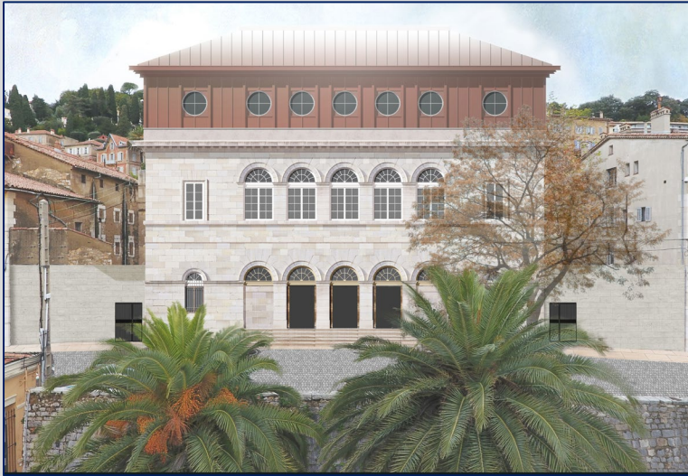
Vue depuis la rue de l'ancien palais de justice
