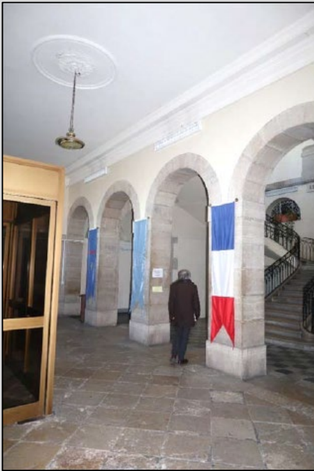
Le vestibule attenant et les sols en pierre
