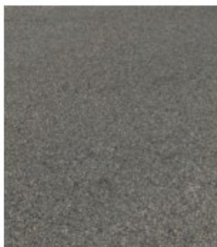
Enrobé clair pour raccordement des trottoirs
