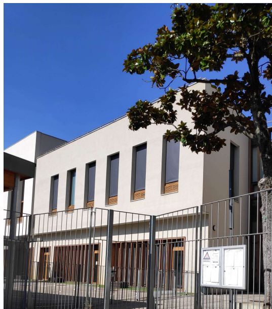
Stores en est-ouest-sud
