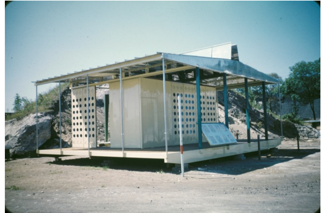
Maison tropicale de Jean Prouvé©, architecture bioclimatique préfabriquée en métal conçue et fabriquée par un ferronnier, architecte autodidacte : les techniques modernes sont mises au service d'une amélioration de la qualité de vie dans les années 1950
