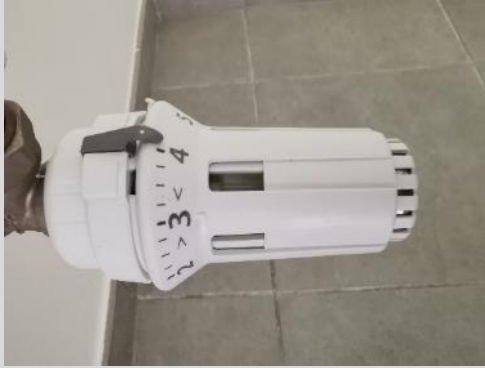
Radiateur à tête thermostatique et régulation via thermostat d'ambiance
