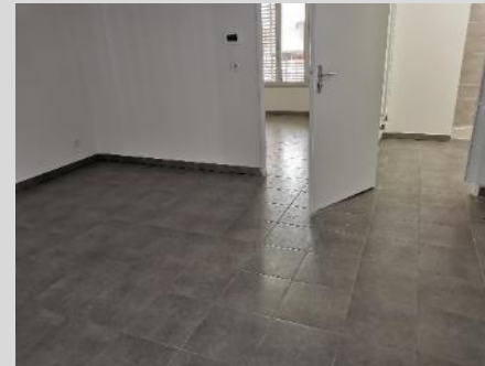
Pose du carrelage, des rupteurs thermiques
