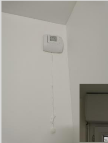
Entrée d'air hygro B, bouche de reprise, WC à double commande
