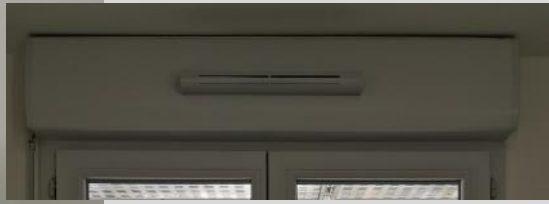
Entrée d'air hygro B, bouche de reprise, WC à double commande
