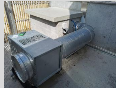
Caisson de ventilation en toiture et pose des jardinières
