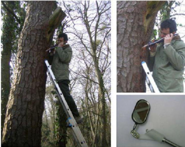
vérification des cavités avant abattage des arbres
