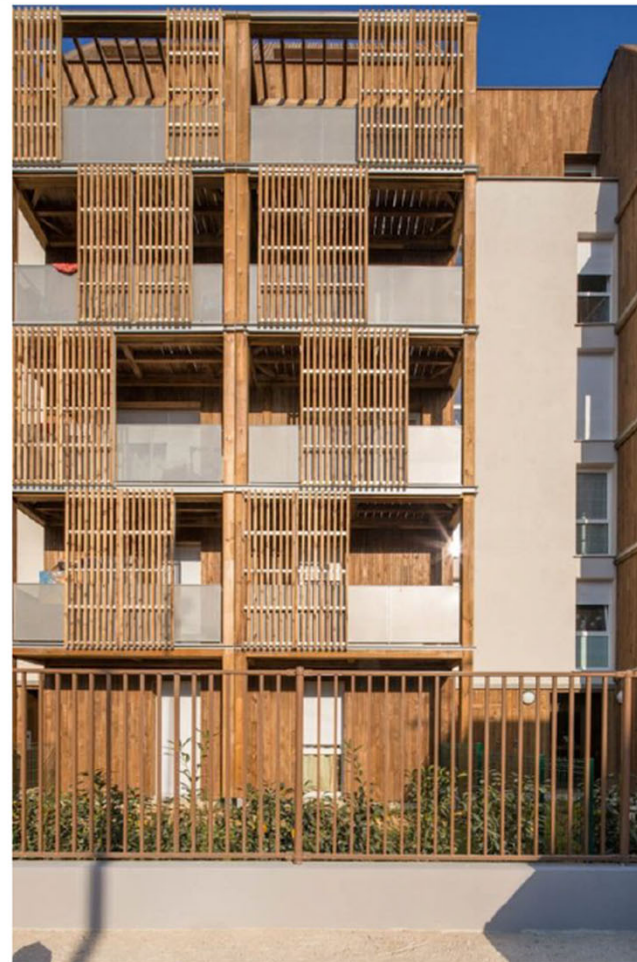
Brises soleils Utilisation de matériaux écologiques Bois en fond de loggia Guérin et Pedroza
