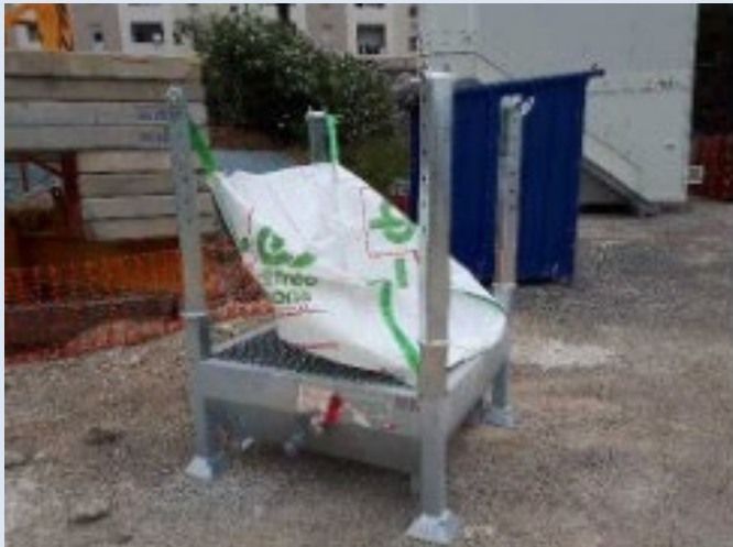
Décantation eaux de lavage béton
