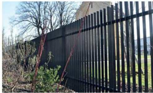
Clôtures de jardin, protection des regards offrant une ouverture lumineuse
