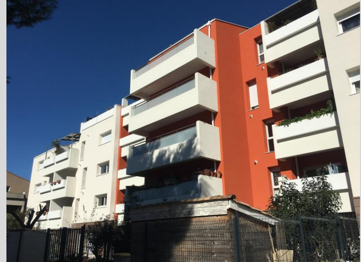
Bâtiment B4-C5-B6-C7 (après travaux)
