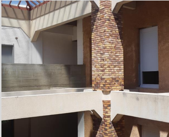
Patio Bâtiment A8 B9 (avant travaux)
