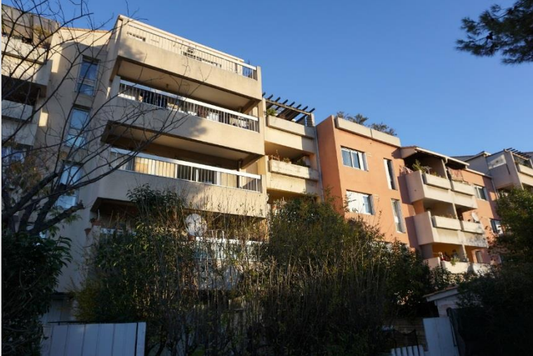
Bâtiment B4-C5-B6-C7 (avant travaux)
