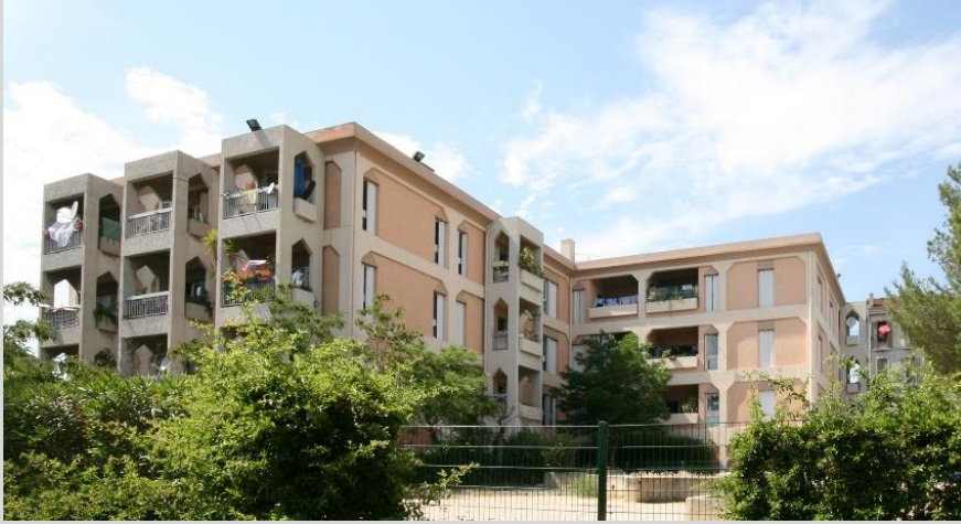
Bâtiment A8-B9 (avant travaux)
