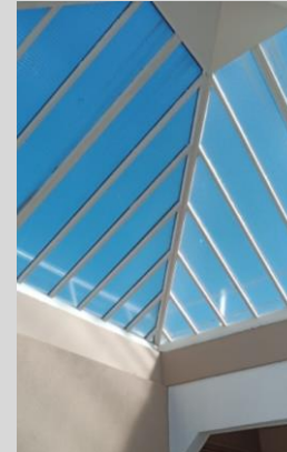
Patio Bâtiment A8 B9 (après travaux)
