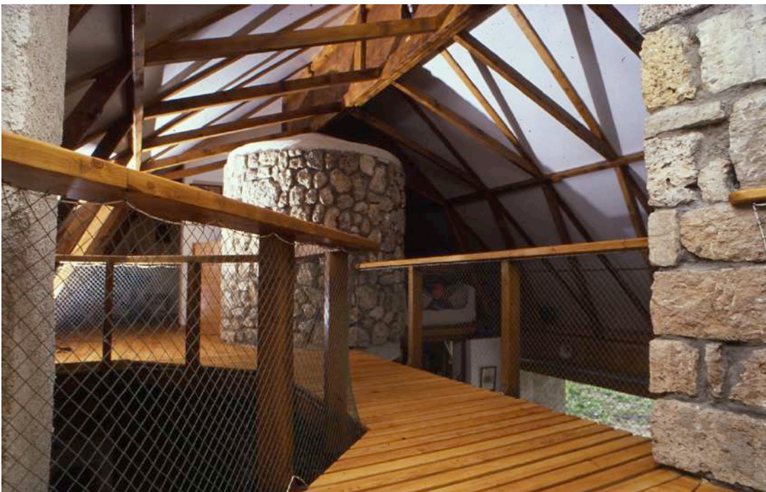
Le réemploi des pierres gélives en intérieur (maison particulière)
