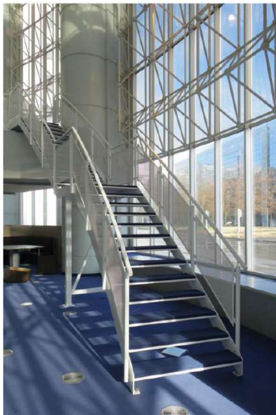
Photographie de l’escalier dans le hall du bâtiment de l’administration flamande, avant son démontage en vue de son réemploi dans le projet Zinneke, 2 février 2018.
