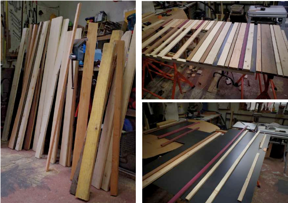
Thibaut Defrance, restaurant le Quart d'heure indien - Ressources disponibles et pré-assemblage testé sur site
