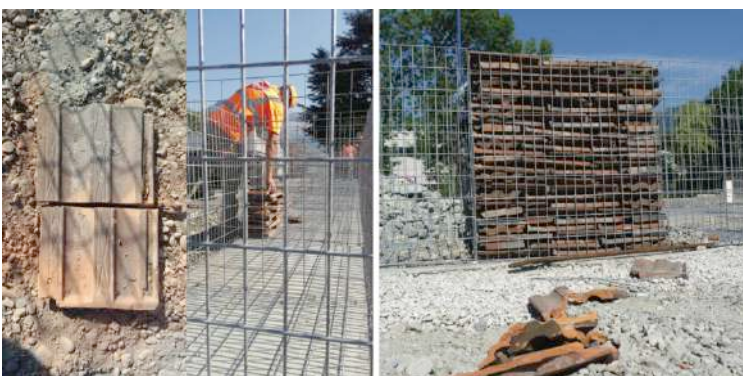
NA ! architecture, déchetterie de Saint-Martin d'Hères - Prototypage et mise au point sur le chantier, 2018
