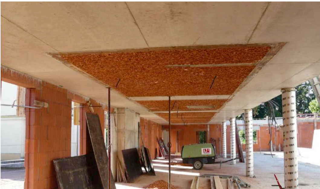
Atelier de l'Entrelacs, mairie de Mably - Bris de tuiles faisant un fond de coffrage
