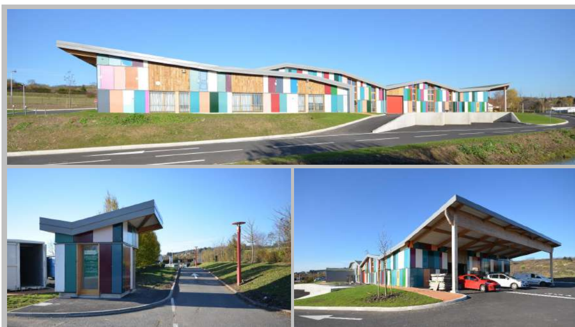
Antoine Bruhat, B&B architectes, la recyclerie de Cusset (03) – vues d'ensemble du bâtiment
