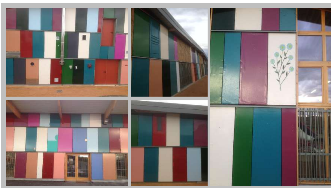
Antoine Bruhat, B&B architectes, recyclerie de Cusset (03) – détails de façades Les portes ont un système de pose simple facilitant leur remplacement
