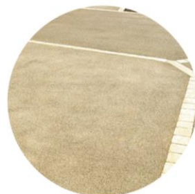
Béton caverneux ocre Perméable
