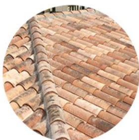
Toiture en tuiles Canales de pays
