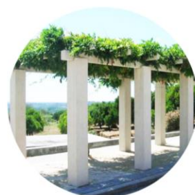
Pergola en béton Ecocem
