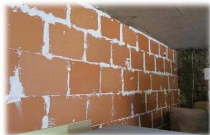
Contre-cloison brique + liège
