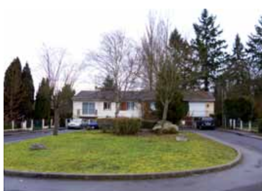
Vue d'ensemble. Plan et image d'un lotissement de maisons Phénix construit par des autoconstructeurs Castor dans les années 1970, situé à la frange d'un bourg de la ville de Sénart.
