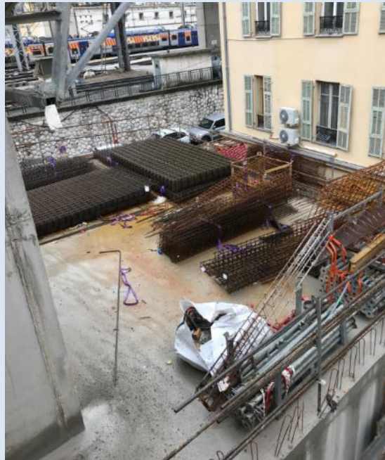
Zone de stockage
