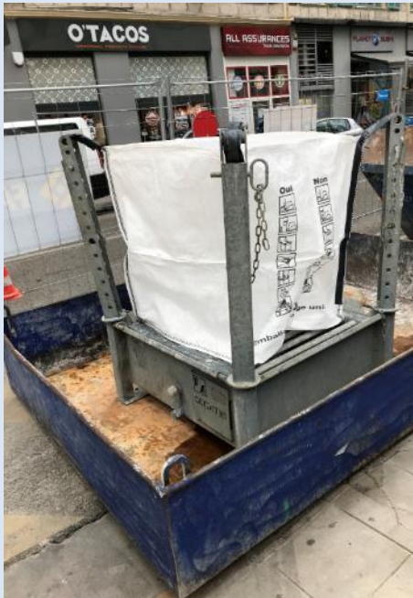
Zone de décantation des eaux béton
