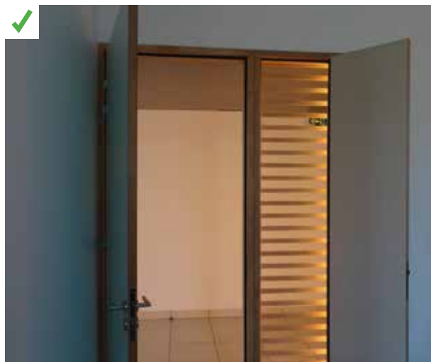
Porte de bureau composée d'une partie fixe persiennée permettant un transit d'air suffisant tout en assurant la fermeture d'accès. Pour des besoins de confort acoustique ou d'intimité, un vantail peut être fermé. ©AQC
