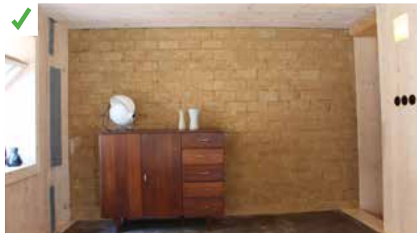
Apport d'inertie dans une construction en bois grâce à une cloison en briques de terre crue. ©AQC
