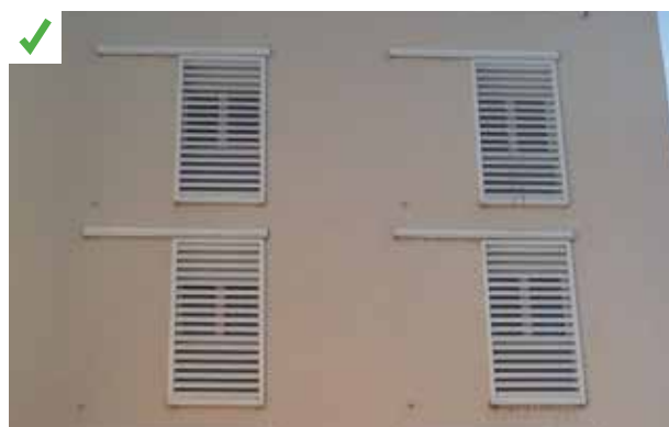
Les occupants de ce bâtiment ont fermé les brise-soleil coulissants sur cette façade exposée ouest avant de partir au travail. ©AQC
