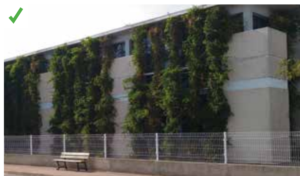
Bon développement de la protection végétale grimpante sur la façade. ©AQC
