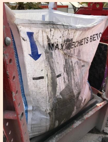
Zone de décantation pour les eaux béton.
