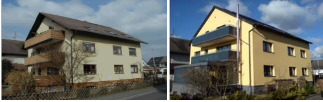
Avant réhabilitation Après réhabilitation
