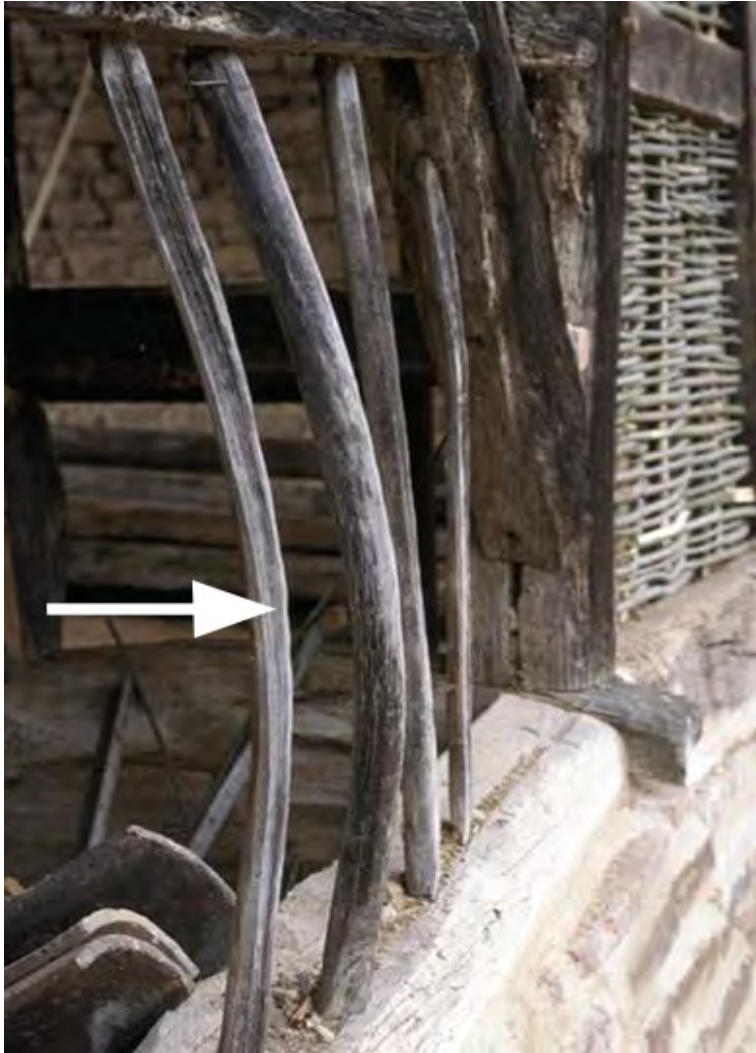
Illustration 8: un palançon, support de clayonnage ou première trame. (© Médiathèque de l'architecture et du patrimoine (Centre de recherche des monuments historiques - CRMH) diffusion RMN, Charles Hurault)
