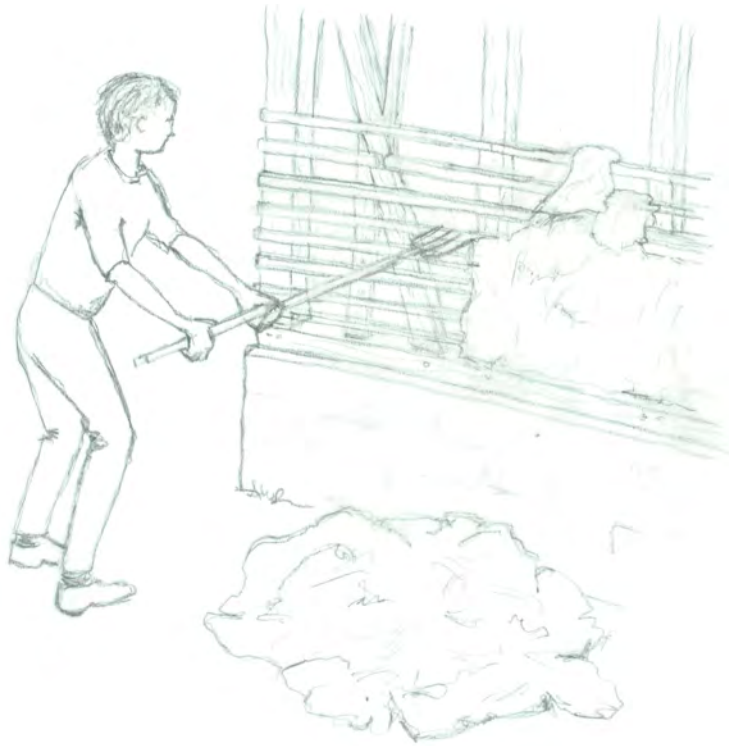
Illustration 33: Pose projetée / rabattue :La personne se met à une certaine distance et projette avec force. Ce type de pose s'effectue parfois directement à la fourche. Il existe aussi des projections mécaniques. Finition par pression verticale.
