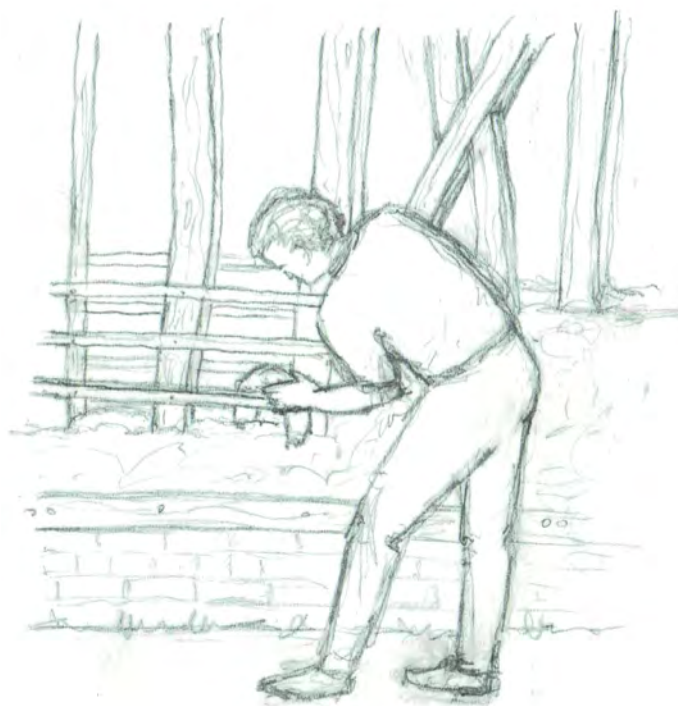
Illustration 28: Pose à cheval : Mise en œuvre sur tout support de fixation suffisamment résistant et espacé pour recevoir une paumée de torchis à cheval. Les poignées se superposent les unes aux autres. Les deux parements peuvent être dressés en même temps par un travail en vis à vis qui nécessite deux poseurs, parfois une banche fixée provisoirement remplace un poseur.
