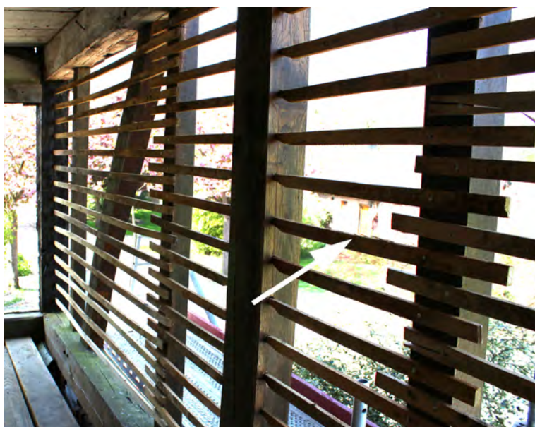
Illustration 16: Lattage formant lattis par endroit (Yan Minne)
