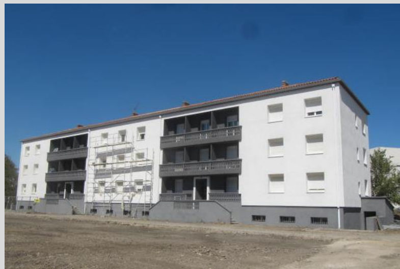
Immeuble existant sur la parcelle
