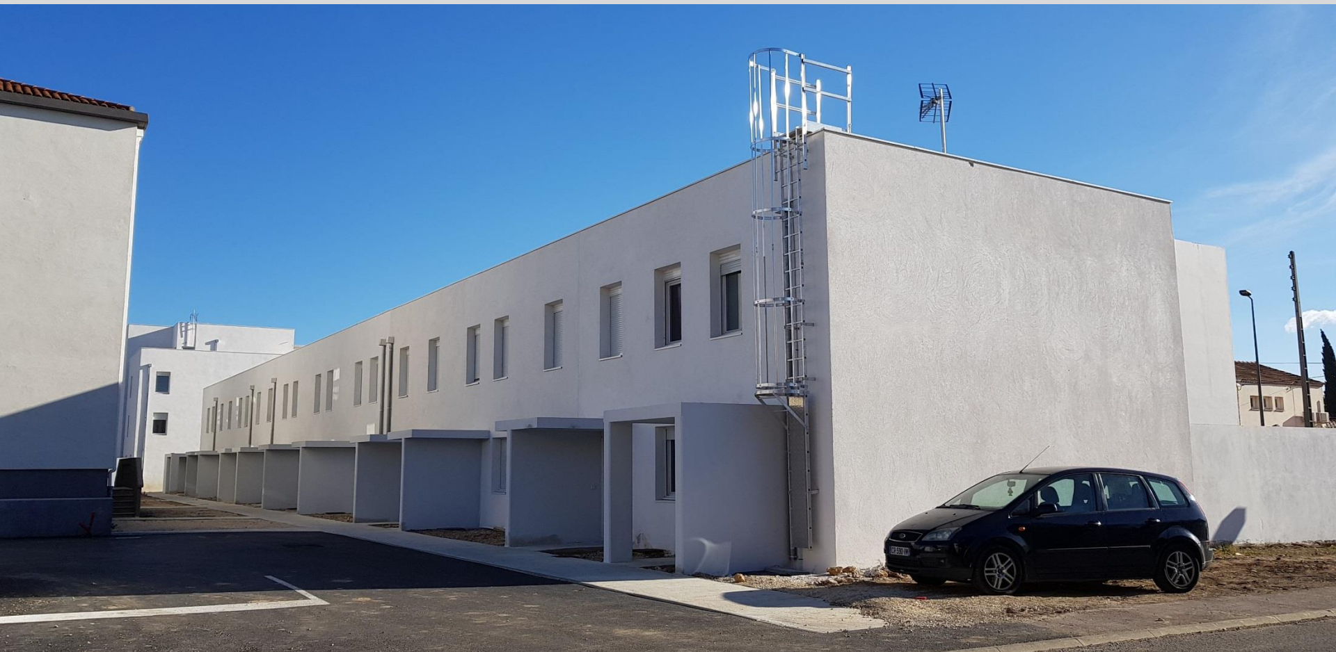
Façade Nord Ouest
