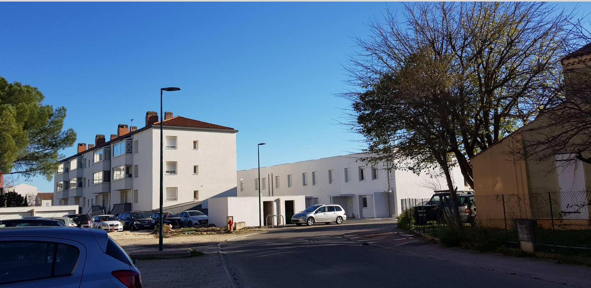
Façade Nord Ouest
