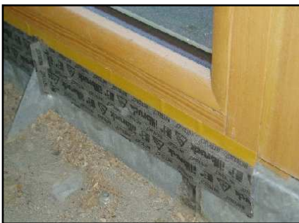
Scotchage de la menuiserie sur sa périphérie (rez-de-chaussée du bâtiment neuf)
