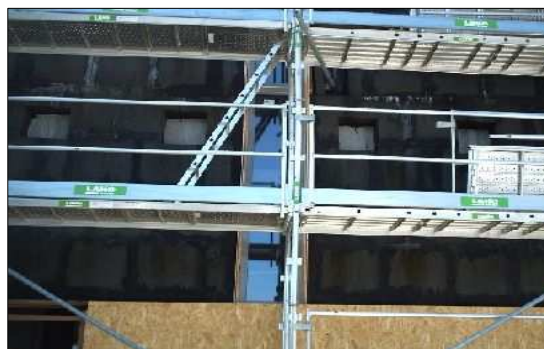
Pose du Foamglas en cours sur la façade nord
