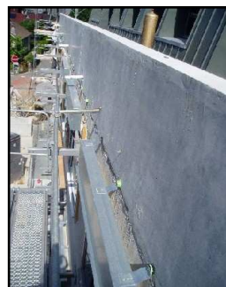
Vue de la façade sud, depuis la terrasse – Fixations mécaniques des brise-soleil
