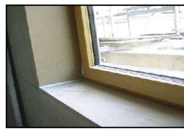
Après tabletage (échantillon réalisé pour essai)
