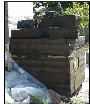
Blocs de Foamglas en attente d'être posés
