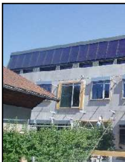
Capteurs solaires thermiques, marque Wagner
