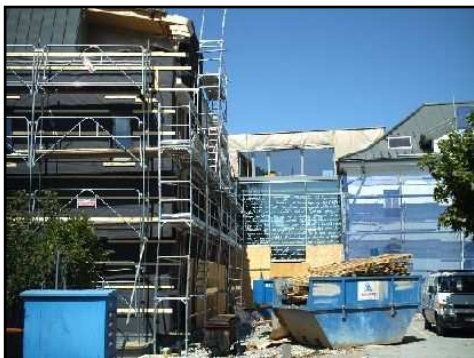
La nouvelle entrée, à la jonction entre l'ancienne mairie (à droite) et l'extension (à gauche)
