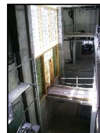
Passerelle d'entrée enjambant le sous-sol et le futur « jardin intérieur »
