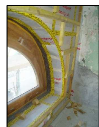
Mise en œuvre de l'ITI et traitement de l'étanchéité à l'air aux pourtours de menuiseries
