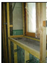
Mise en œuvre de l'ITI et traitement de l'étanchéité à l'air aux pourtours de menuiseries
