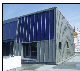
Membranes photovoltaïques
