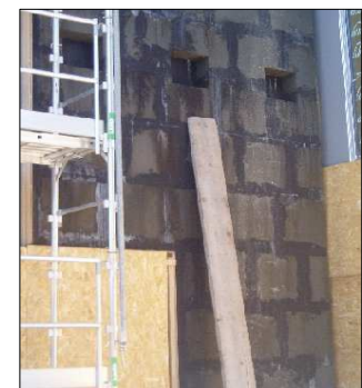
Pose du Foamglas en cours sur la façade nord
