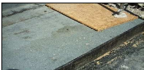
La dalle du sous-sol est également isolée avec 20 cm de Foamglas
