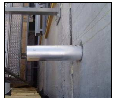
Vue de la façade sud, depuis la terrasse – Fixations mécaniques des brise-soleil
