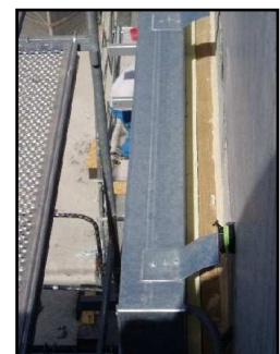
Vue de la façade sud, depuis la terrasse – Fixations mécaniques des brise-soleil
