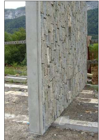
Fabrication des murs en usine : avant le coulage du béton et après décoffrage – source : De Jong Architectes
