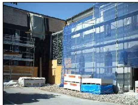
Etat des travaux au 28/07/09. Rénovation à droite, extension à gauche
