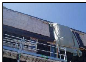
Emplacement réservé pour le bardage en zinc, façade sud
