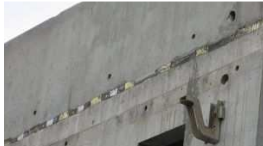
Rupteur de pont thermique (source : De Jong Architectes)
