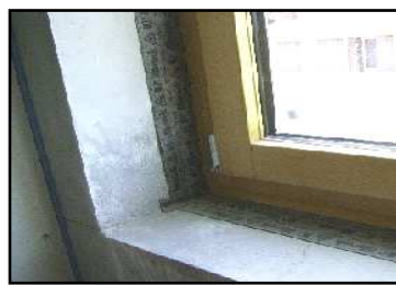
Scotchage avant tabletage
