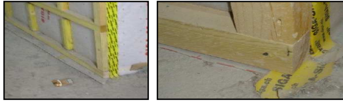
Joint butyle, liteaux et scotch Siga-Sicrall® en haut et pieds de façade
