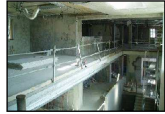
1 er et 2 ème étage du bâtiment existant, en cours de rénovation
