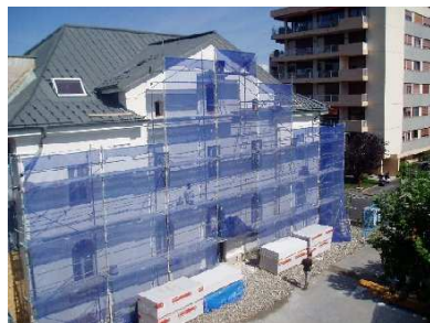
Façade Est de l'ancienne mairie en cours de rénovation
