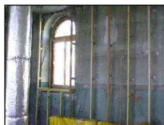
Mise en œuvre de l'ITI et traitement de l'étanchéité à l'air aux pourtours de menuiseries
