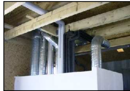
Regroupement de la tuyauterie au second étage, dans l'extension
