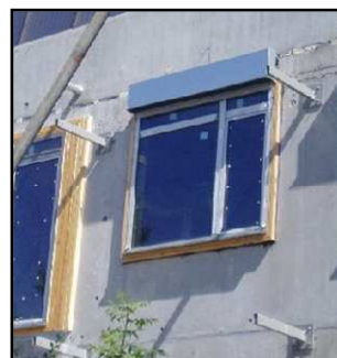
Vue de la façade sud, depuis la terrasse – Fixations mécaniques des brise-soleil
