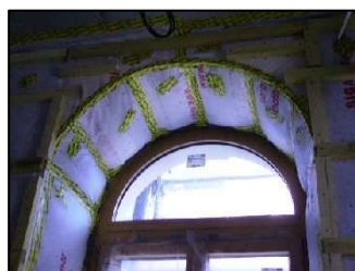
Mise en œuvre de l'ITI et traitement de l'étanchéité à l'air aux pourtours de menuiseries
