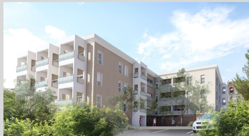
Bâtiment A8-B9 (après travaux)
