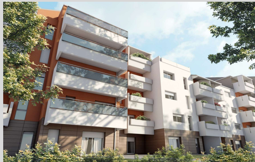
Bâtiment B4-C5-B6-C7 (après travaux)
