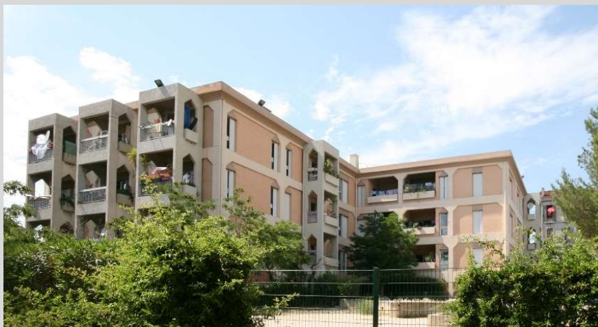
Bâtiment A8-B9 (avant travaux)
