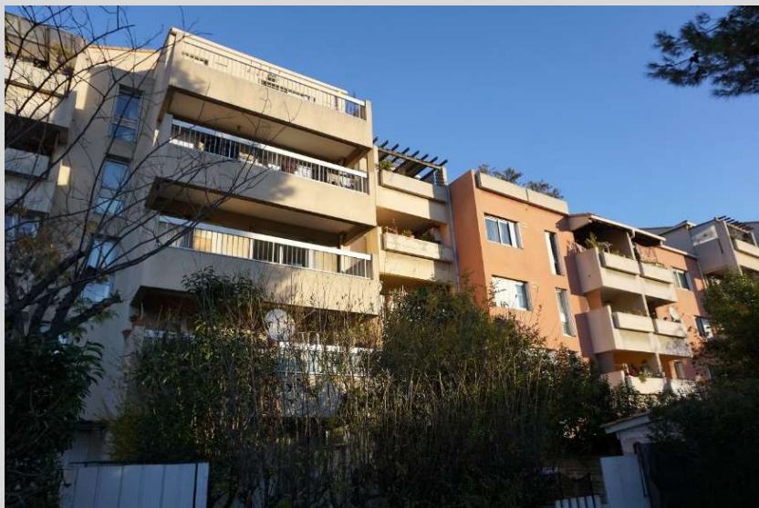
Bâtiment B4-C5-B6-C7 (avant travaux)
