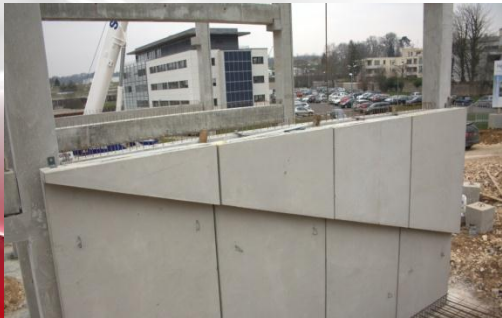
Pose des soubassements préfa
