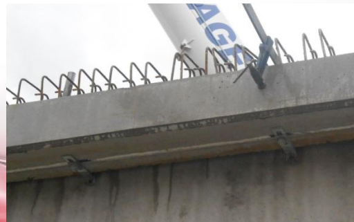
Fixation des panneaux à la structure porteuse
