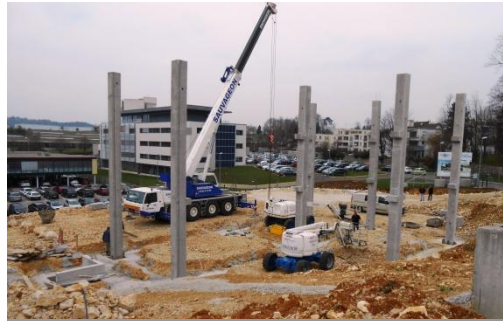
Pose des poteaux
