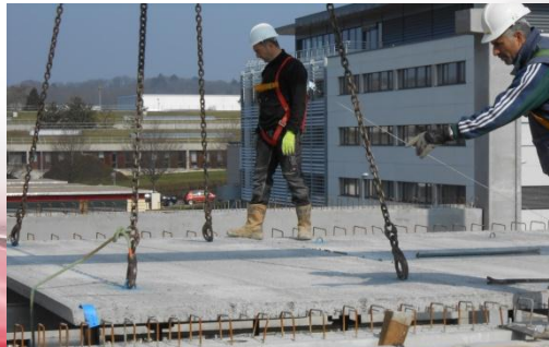
Pose des prédalles
