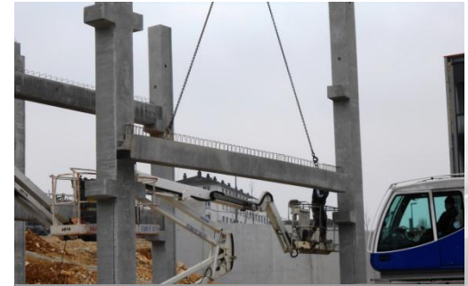
Pose des poutres
