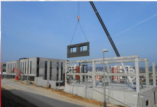
Montage des panneaux
