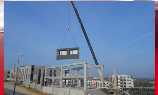
Pose des panneaux façades
